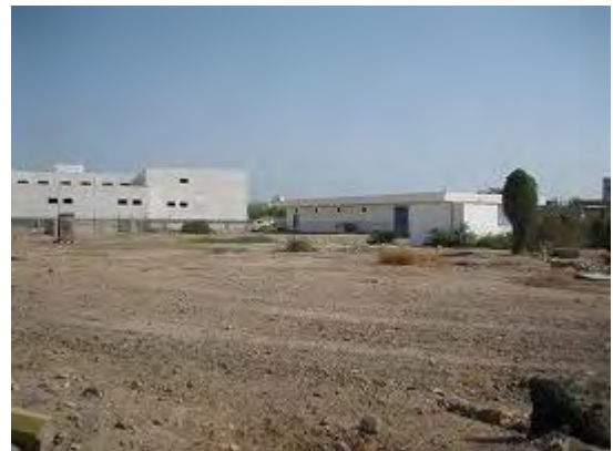
PVモジュール設置箇所 2
