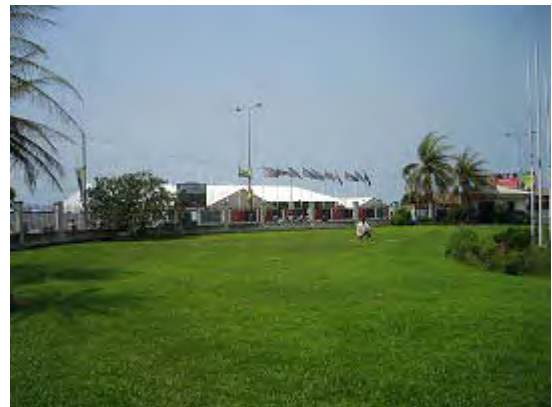
PV モジュール設置箇所 2
