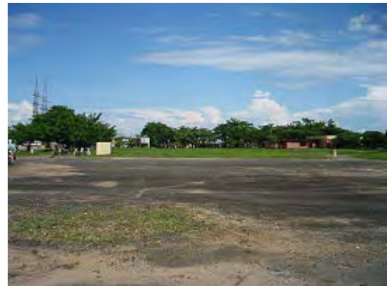
PV モジュール設置箇所 2
