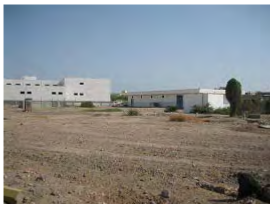
PV モジュール設置箇所 2
