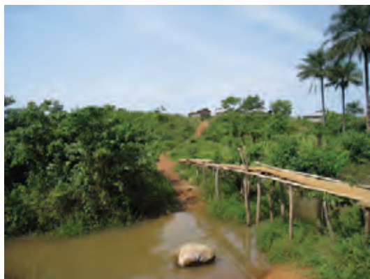
No.451 Moses Blah Rd. (今回不採用) アクセス道路が未整備 (写真奥が人道) のため今回不採用。
