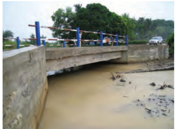
写真 4-1 18 New Georgia 架替済橋梁
