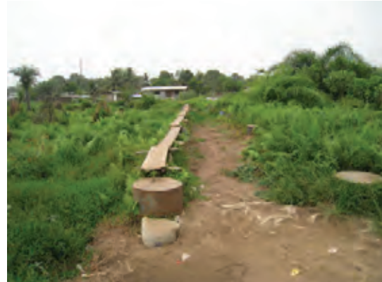
No.461 Zubah Town Rd. (採用) 最長となる L=36.0m で計画。新橋位置は写真右側にリアラインする。
