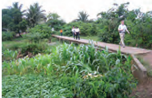
No.329 Kearduma Community Rd (今回不採用) アクセス道路が未整備で建設重機の搬入が困難なため今回不採用。
