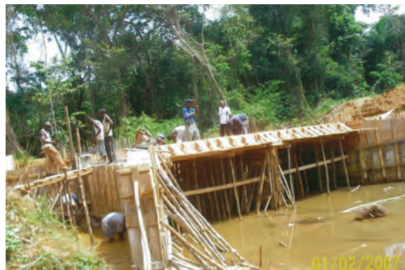
写真 6-5 施工中の橋梁
