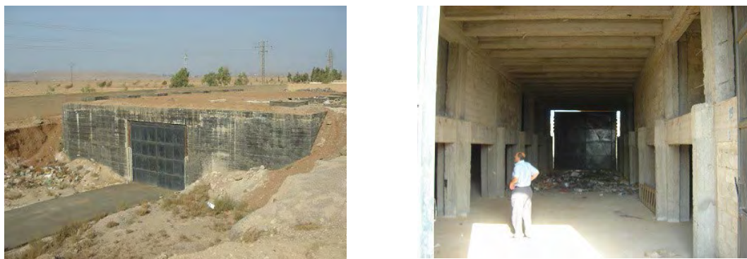
図2-7 ダマスカス市ゴミ処分場内の危険物処理庫
