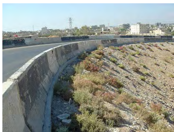
インターチェンジ路肩部
