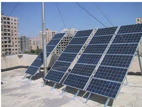
NERC 庁舎屋上
