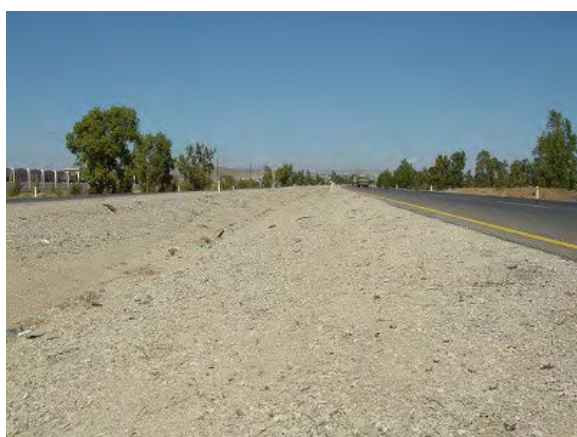
中央分離帯 (街灯設置位置)
