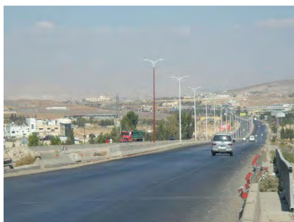
Damascus-Jordan 道路 (既設街灯設置区間)
