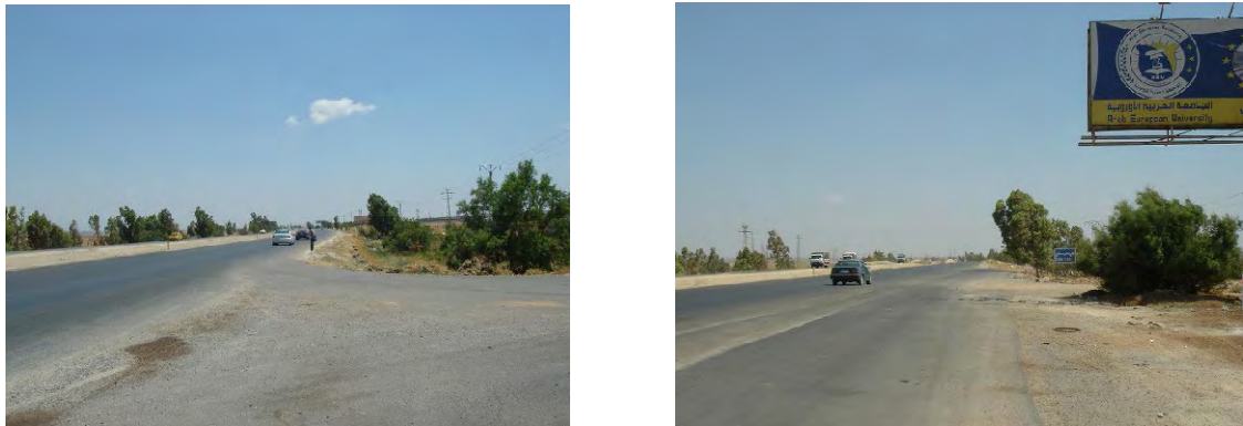
図2-5 調査対象道路の状況
