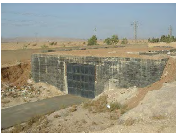
使用済み蓄電池保管庫
