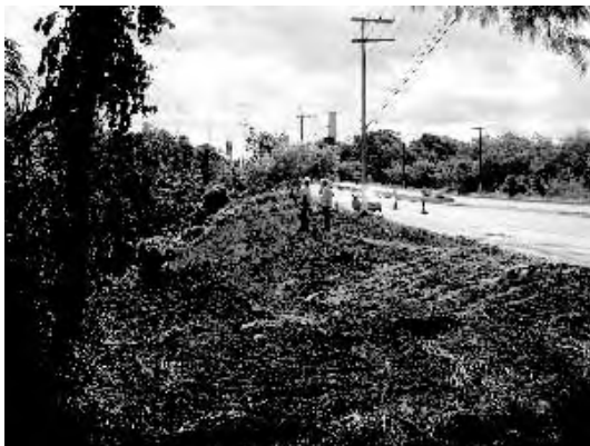
Local limpo e restaurado no DI 1
