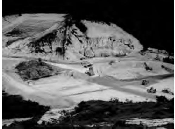
マナウス市の処分場の拡張地域の建設工事の光景である。
