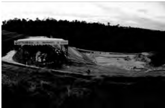
工場地区 (DI) 2に建設された民間処分場。
