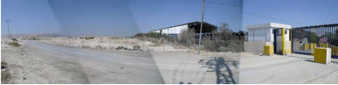
写真-1 : 農工業団地予定地隣接の再生鋼加工工場ゲート付近。写真中央より左側が計画予定地。右の小屋が JDECO 管理の既存開閉所で、本件と接続させる計画とする。
