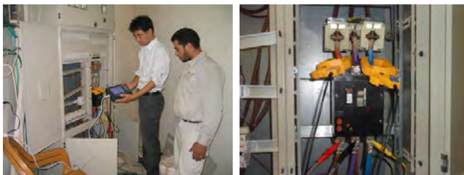
写真左：電圧および周波数変動の測定作業 写真右：配電盤への測定器設置状況
