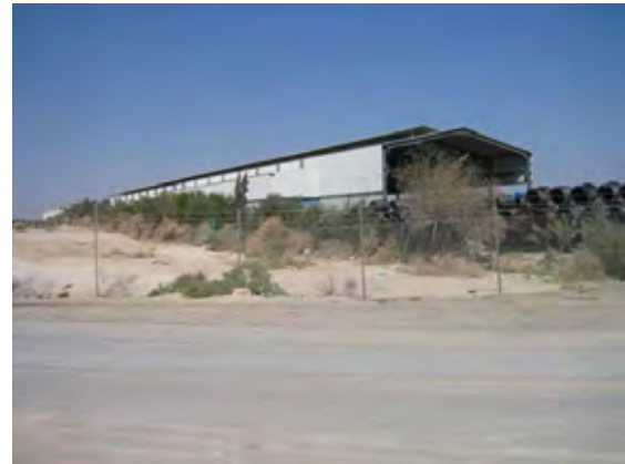
写真-3 : 敷地東側に隣接する再生鋼加工工場建物の日影による影響が出ない様に考慮し、PV パネルの配置を行なった。
