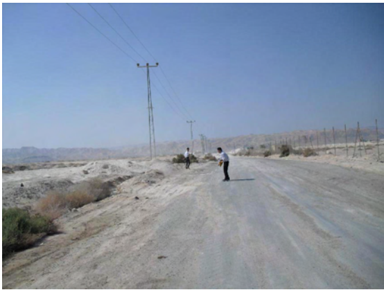
写真-2 : 再生鋼加工工場への配線状況。約 80m 間隔の鉄塔で 33kV にて送電されている。
