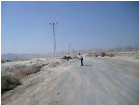
写真-2 : 再生鋼加工工場への配線状況。約 80m 間隔の鉄塔で 33kV にて送電されている。
