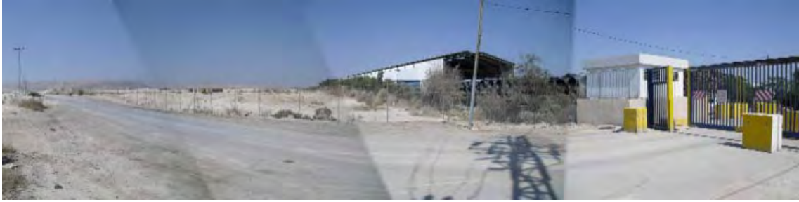
写真-1 : 農工業団地予定地隣接の再生鋼加工工場ゲート付近。写真中央より左側が計画予定地。右の小屋が JDECO 管理の既存開閉所で、本件と接続させる計画とする。
