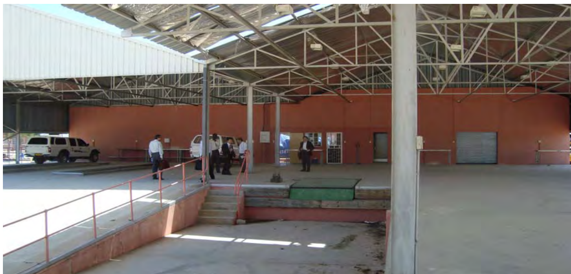
図４－８ 通関貨物検査場
