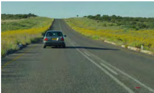
ボ国側路面状況
