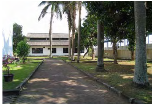
本館脇の敷地内通路から計画サイトを望む （通路幅は約3.0mで大型機材の搬入に利用可能。）
