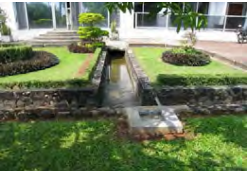
宿泊棟傍の水栓 (既存埋設管から分岐し、計画施設への給水可能。)
