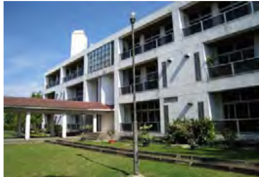
宿泊棟上部の高置水槽 (6t) (水槽高:約 18m、本館 1 階の水圧は高い。)
