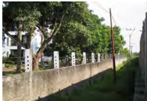
計画サイト裏の排水路 (水路に沿って高圧送電線あり。)
