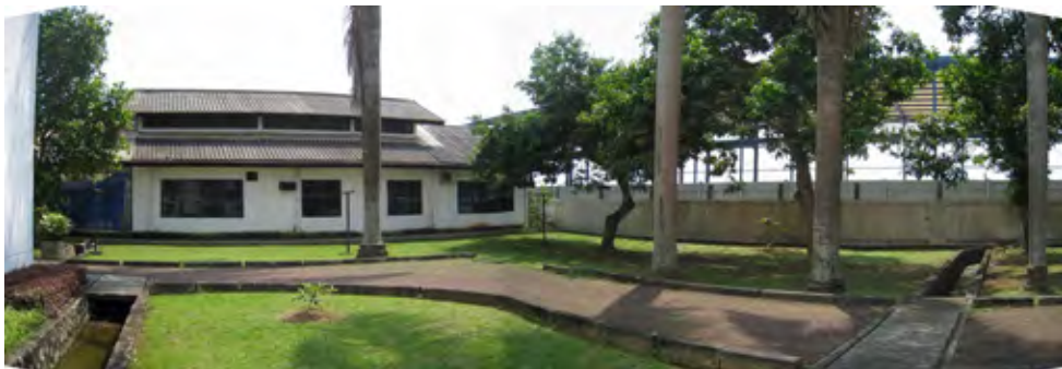
計画サイトの東側から増築部分敷地を望む（正面の建物は、B棟。）
