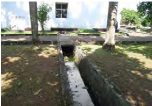
PFI構内の雨水排水溝(雨水排水溝が整備され、大雨による冠水被害なし。)
