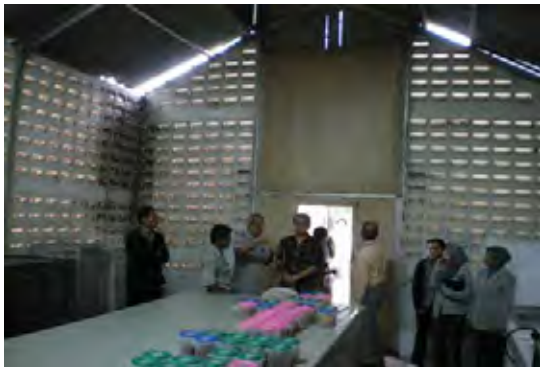
蒸熱処理 (VHT) 設置予定建物内部
