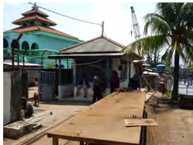
IV②. 排水機場守衛棟 (P-14) 排水機場の警備を担当している建屋。東排水機場取水路側の横(東側)にある。
