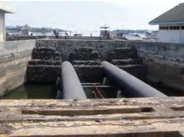
V③. 東排水機場放流管 3 (P-24) 仮復旧工事完成写真。
