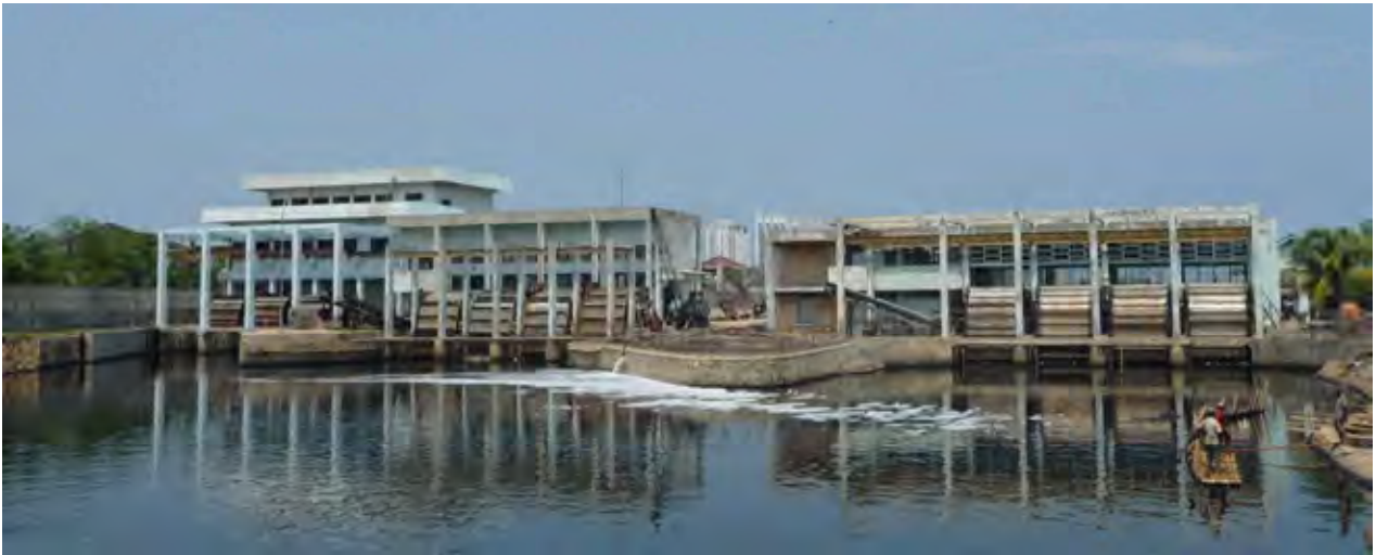
I ①. プリット排水機場の全景 (P-1)
