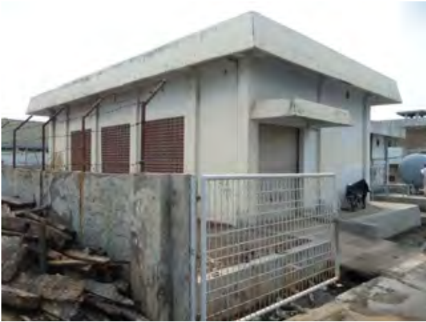
IV⑤. 非常用発電機室 (P-17)
