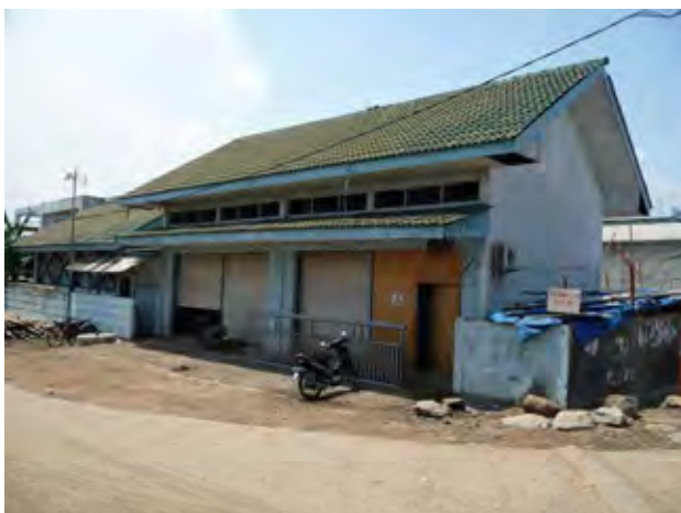
IV①. 排水機場倉庫・オペレーターハウス (P-13) 排水機場の倉庫(写真右)と、排水機場の運転・維持管理担当者数名の自宅(写真左)として使用されている。東排水機場排水路の横(東側)にある。
