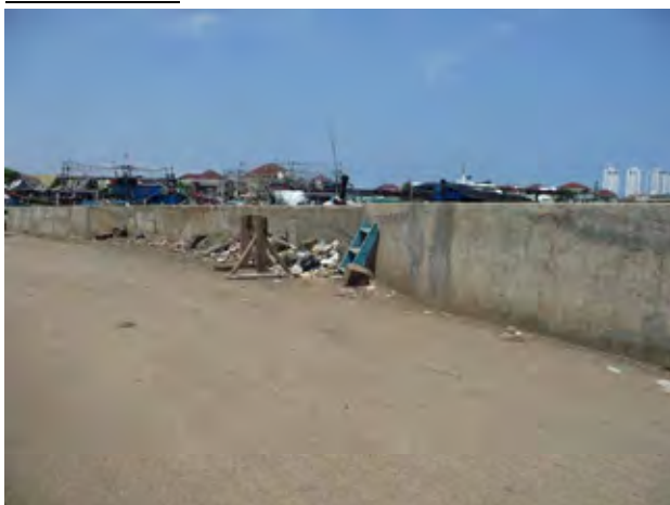
II ①. 防潮堤 (P-7) 東排水機場前の防潮堤。
