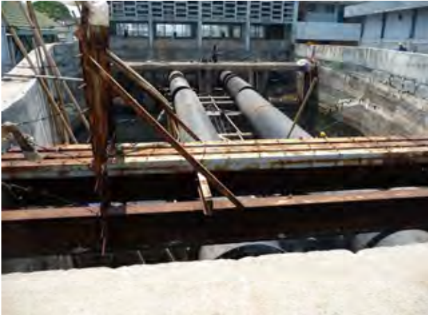
V①. 東排水機場放流管 1 (P-22) 中央の 2 本分の仮設排水管が DKI により建設中。(防 潮堤側から撮影)
