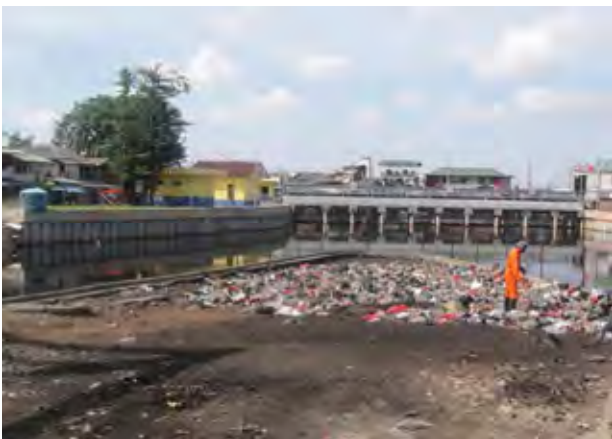
IV⑨. 工事中のスクリーン (P-21)
