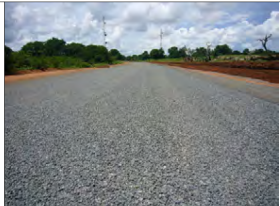
完成した道路表面
