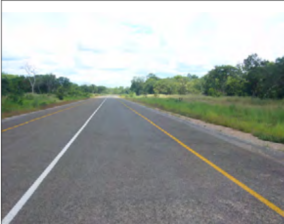
(参考) Unity Bridge (中国業者の施工)のアプローチ道路の全景
