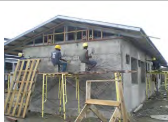
事務所棟海側から望む。外壁の左官工事中。
