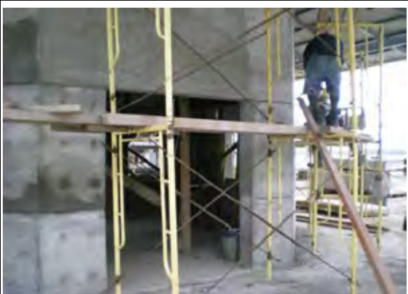
キオスクの施工状況。屋根工事、塗装前下地処理の一部の他、仕上げ工事が残っている。
