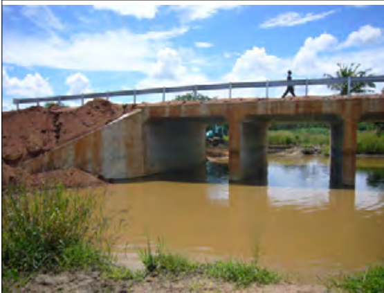
ボックスカルバート (起点から 31km)
