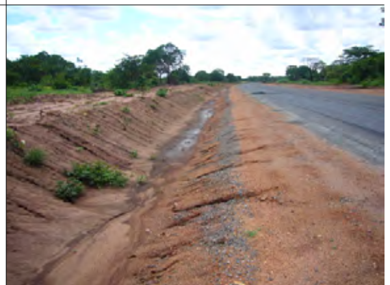
土側溝。ラテライトは植生が付きにくいし、簡単に雨で法面が崩れる。
