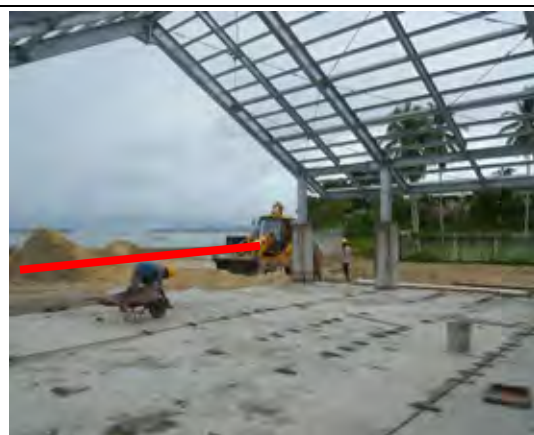
市場敷地の海岸側（赤線の向こう側）が先方施工により埋め立て拡張されている（最大幅 30m程度）。車両も通行する予定。
