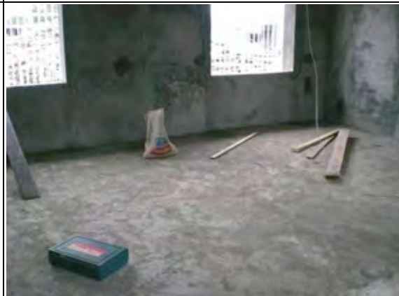
事務所棟保管庫。仕上げ工事中
