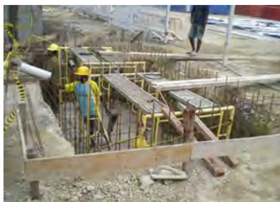
公衆トイレのセプティックタンクの工事状況。掘削し、底盤コンクリート打設終了後、地下壁の配筋作業中
