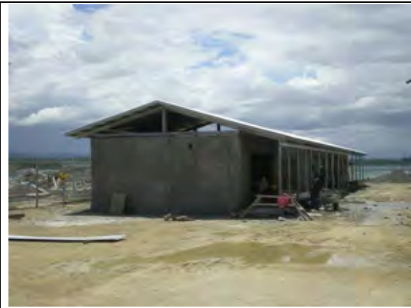
公衆トイレ(手前側)、事務所棟(奥側)の全景。手前の敷地は当初のゴミ集積場の設置を駐車場からの出入口に変更。
