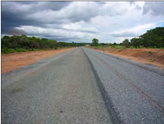
右側が3層目の砕石を敷設した後。左は補修前。
