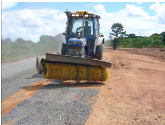
白線を引く前に浮いた碎石を除去
