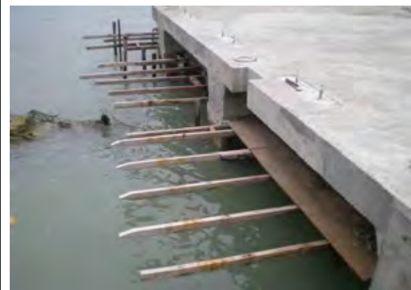
新栈橋上部工まで完了。下型枠は潮位が低い時を見て撤去予定。車止め固定用ボルト、係船環及び階段取り付け箇所の切り欠きの状況
