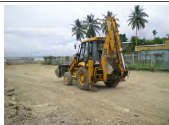
市場棟Ⅲ側予定地の ILB 施工箇所。整地作業を実施中。この後栗石入れ、砂ベッドの施工後、ブロック設置工事となる。
