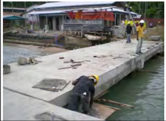
渡り栈橋全景、下型枠は一部を除き撤去。表面のモルタルによる手直し中。
