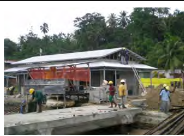
製氷棟全景と渡り栈橋 製氷棟は仕上げ工事中、渡り栈橋は上部工まで完了
