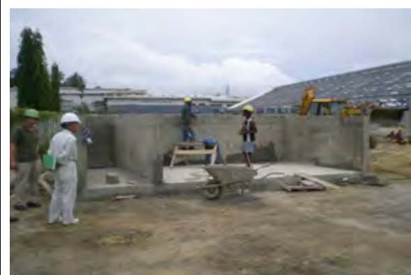
ゴミ集積場の施工状況。ほぼ完了し、モルタルによる補修作業中。
