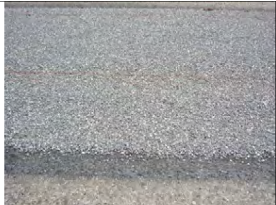
補修後の舗装表面。密に砕石が敷き並べられている。
