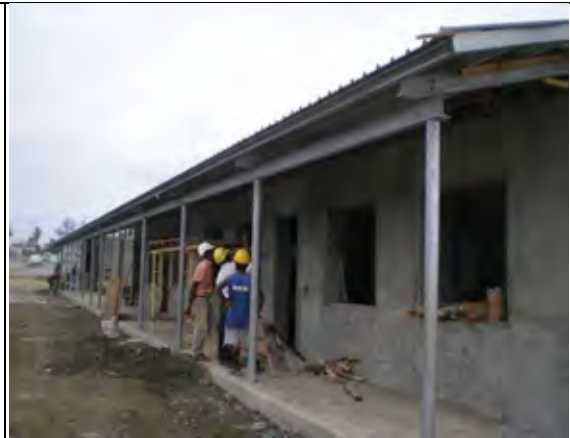
事務所棟の施工状況。屋根工事は終了し、内外装の仕上げ工事中
