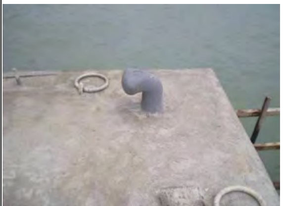
新栈橋の係船環、曲柱の設置状況 全数設置済み
