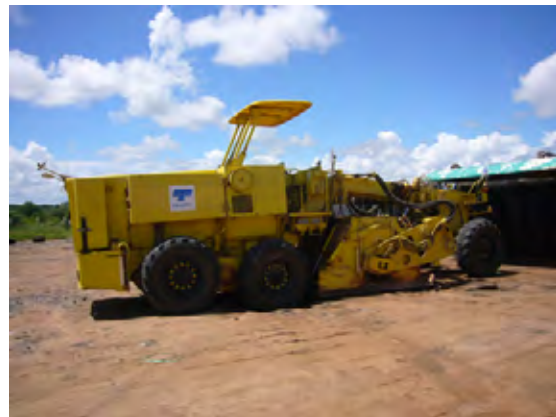
路盤のセメント安定処理機械
