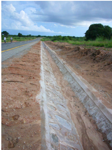
Phase1 工事部分で TANROADS が独自に行った側溝の法面保護。ほとんど土砂で埋まっていない。
