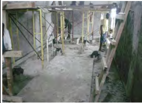
製氷機設置場所。内壁の左官工事。仕上げ工事が行われた後に製氷機などを設置予定。
