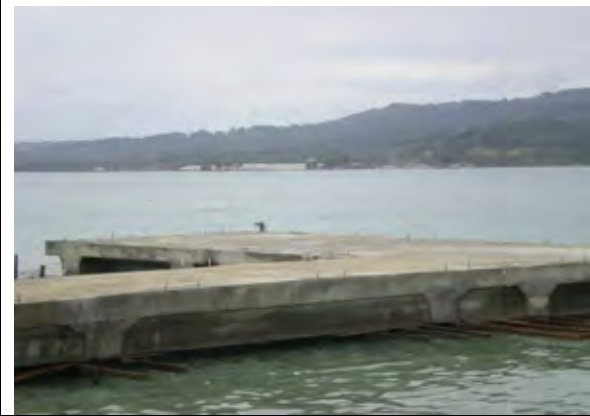
新栈橋全景。上部工まで終了。防舷材、車止め、はしご、防食工が残されている。
