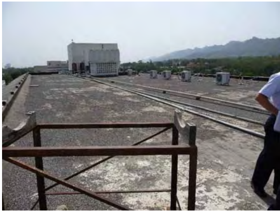
写真 3: 計画委員会建物屋上。設置サイトとして検討されたが、普及啓発効果が劣ること、資機材の搬入が困難なことから設置サイトとはならなかった。
