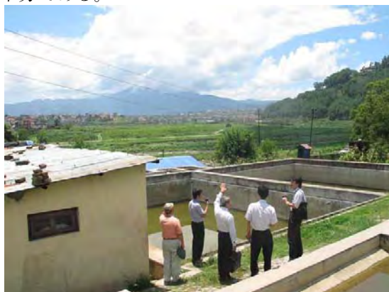
写真 5: スンダリガット浄水場。奥の緑地に見える部分が太陽電池モジュール設置予定の貯水池計画地である。
