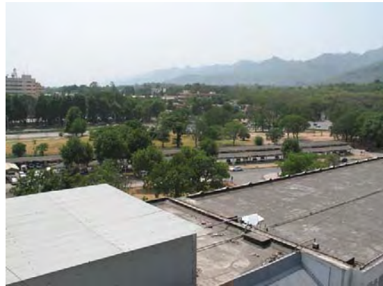
写真 4: 計画委員会建物屋上から駐車場を望む。設置スペースは十分に確保できる。
