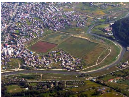
写真 1: 設置予定サイト周辺(航空機内より撮影)。必要面積を確保できるカトマンズ盆地内では数少ない利用可能な敷地である。
