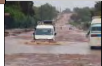
カルバート No. 14 : 強雨時にオーバーフロー
