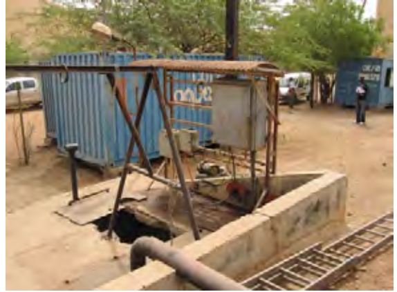
Station de traitement des eaux usées de Kaolack [Gauche] Lagune construite en 1981 (Capacité : 600 m 3 /jour) (une série), [Droite] Pompe de refoulement : extrêmement vétuste
