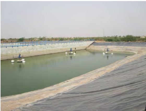
Station de traitement des eaux usées de Kaolack [Gauche] Lagune aérée développée en 2008 (Capacité : 6.000 m 3 /jour), dispositif d'aération non opérationnel, [Droite] Nappe étanche du bassin d'aération : perte d'eau à l'extrémité de la nappe détériorée
