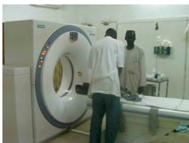
Scanner en cours d'aménagement
