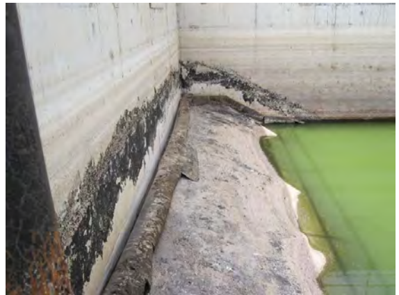
Station de traitement des eaux usées de Kaolack [Gauche] Lagune aérée développée en 2008 (Capacité : 6.000 m 3 /jour), dispositif d'aération non opérationnel, [Droite] Nappe étanche du bassin d'aération : perte d'eau à l'extrémité de la nappe détériorée
