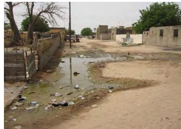
Kaolack 市内下水道未整備地区の状況
