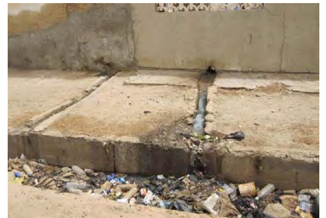
Kaolack 市内雨水排水渠の状況
