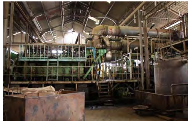
Bel-Air 発電所内部の状況
