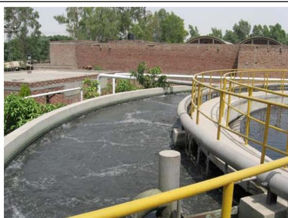
写真-6 反応槽の状況 (繊維工場)
