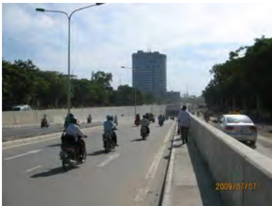
Underpass の壁面 (型枠のはらみ・ズレのため平坦 性がやや悪い)
