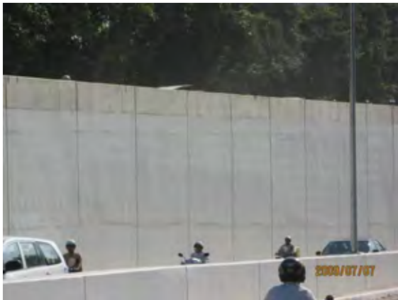
Underpass の壁面 (型枠のはらみ・ズレのため平坦 性がやや悪い)
