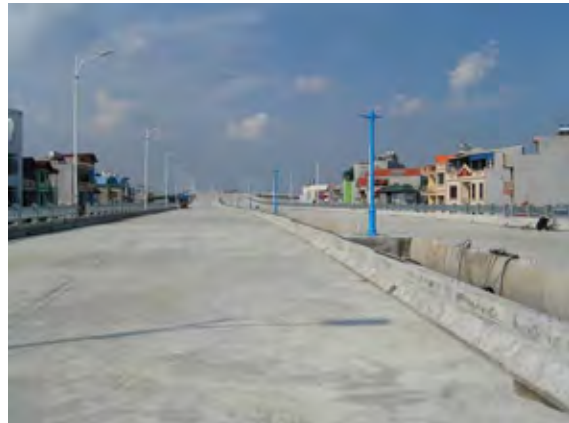
Vinh Tuy Bridge の床版：発展途上国の工事と してみればまあまあの平坦性？
