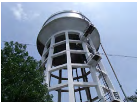
【ブラフモンバリア（一般市庁）の高架水槽】井戸からの地下水を高架水槽を経由して配水している。
