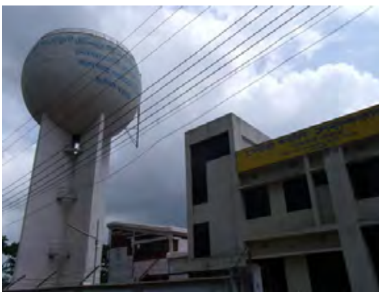
【ノアカリ（一般市庁）の高架水槽】鉄除去施設場内にある。ろ過池の逆洗にも使用されている。
