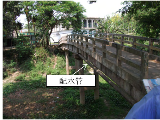
【ケラニガンジ県ファナガール村 配水管の布設の様子】
