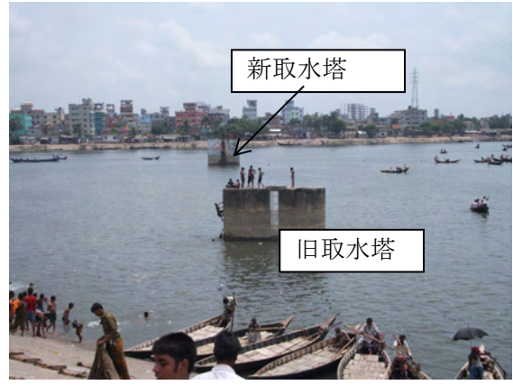
【ダッカ WASA チャンドニガット浄水場】 取水施設を望む。浄水場から 1km の距離にあり、旧取水塔は河川流量低下のため使用されていない。
