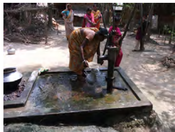
【ガジプール県ロックヒプール村の浅井戸ハンドポンプ】水汲みの様子。
