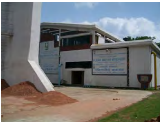
【ノアカリ（一般市庁）の鉄除去施設】DANIDAの援助によって建設された施設。散気による鉄酸化+急速ろ過による鉄除去。
