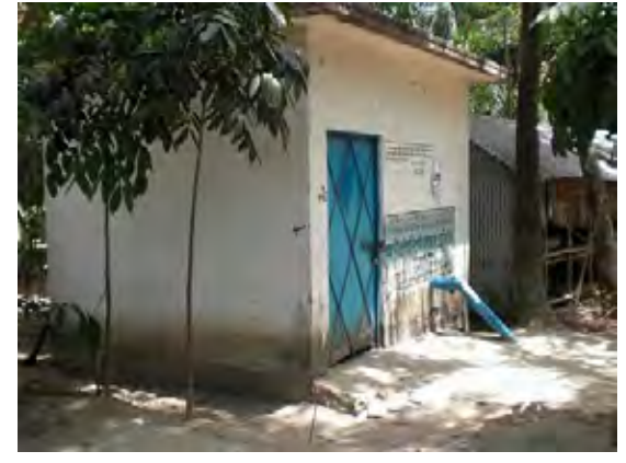
【シャリアットプール（一般市庁）井戸ポンプ室の外観】
