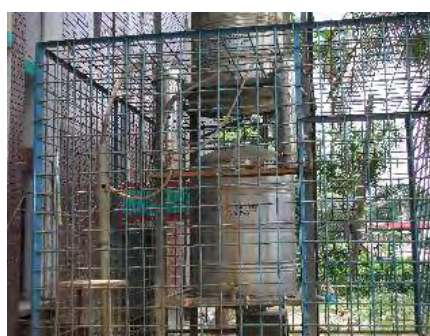
図 3.12-3 SIDKO コミュニティ用 砒素除去装置
