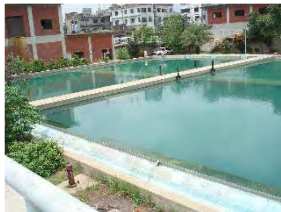
図 3.13-2 チャンドニガット浄水場 沈殿池
