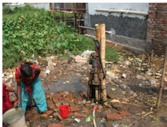
【ダッカ市近郊のスラム】浅井戸ハンドポンプ一本を共同で使用している。
