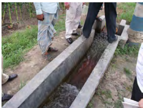
【チャンドプール県カチュア郡】地下水を灌漑水に使用している用水路】
