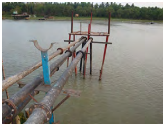
【チャンドプール（一般市庁）の浄水場取水点】市内中心地にある。
