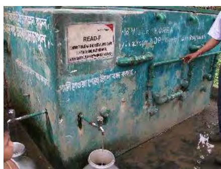
図 3.12-2 READ-F コミュニティ用 砒素除去装置
