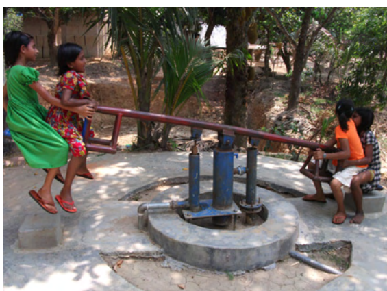
【ガジプール県ロックヒプール村 NGO による水道・衛生プログラム実施例】学校内にある井戸で、シーソー利用。井戸からの揚水と高架水槽への揚水の2機能がある。
