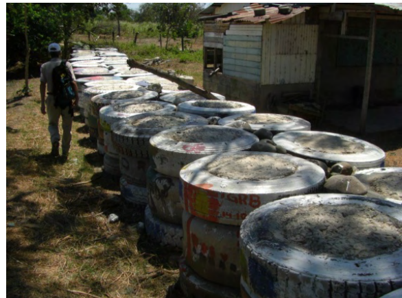
施工済みの古タイヤ堤防 (コスタリカ カーニャス市ホテル地区)
