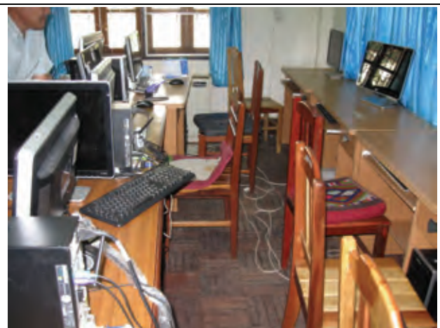
写真-9 National Land Management Administration(NLMA) NLMA のリモートセンシング室。LAN 配線、電源ケーブルが床上に配線されている。面積は不足している。
