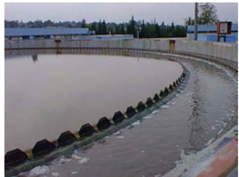
HOMS: 下水処理場の沈殿池
