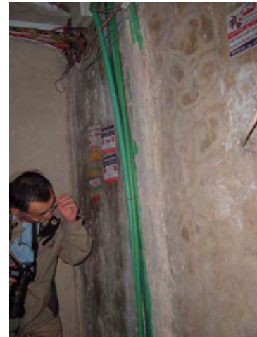
RDAWSSA: 同ジャマラナ WEU の屋内給水管
