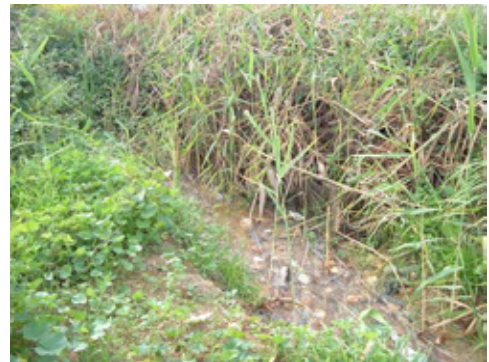
LATTAKIA: 第2導水管ルート沿い漏水による小川
