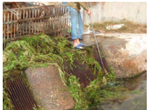
LATTAKIA: シン湖水源の手動取水スクリーン
