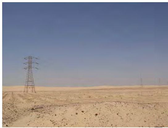
ナイル渓谷西側の 220kV 送電線
