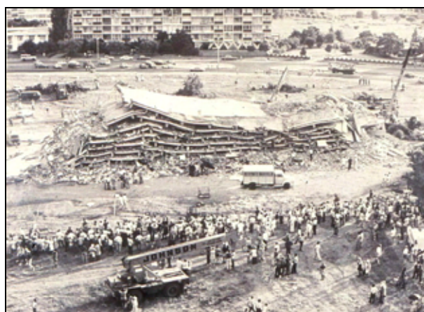
図 2-3-2 1976 年 Welkom での鉱山地震による建物被害状況
