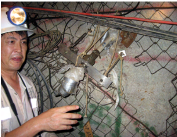
写真 17 【Mponeng 鉱山】 孔内変位計による観測状況
