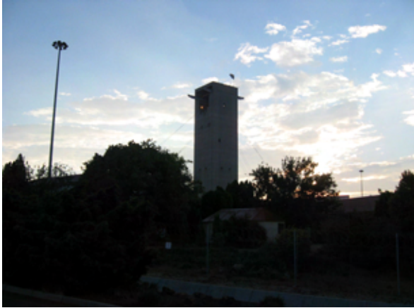
写真 13 【Mponeng 鉱山】 Shaft（中央昇降エレベーター）全景
