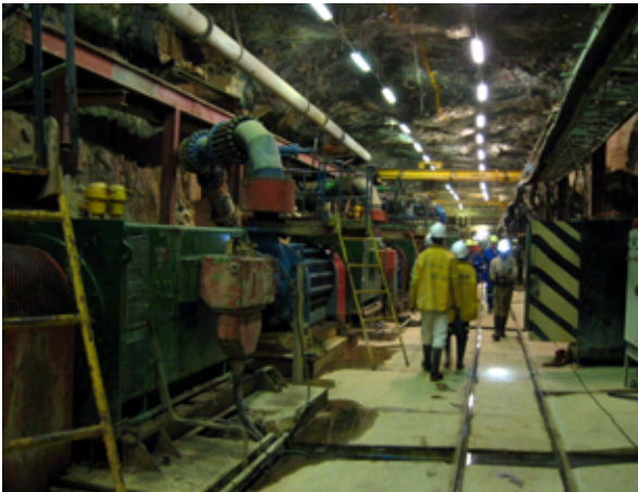
写真 21 【Ezulwini 鉱山】 鉱山内換気システム施設
