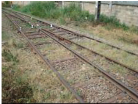
Hình 2.2.5 Tà vẹt bê tông và liên kết ray tà vẹt Vossloh
