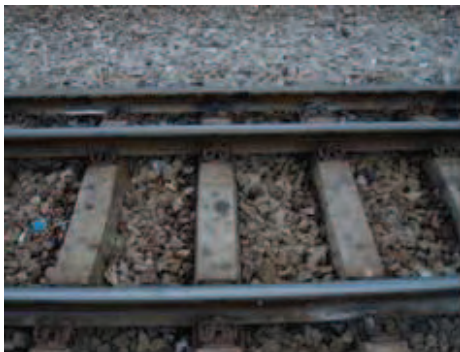
Hình 2.2.5 Tà vẹt bê tông và liên kết ray tà vẹt Vossloh
