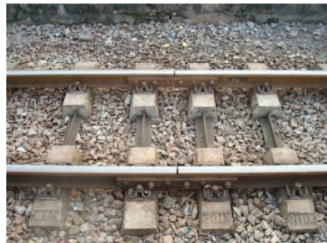
Hình 2.2.6 Khớp nối ray treo
