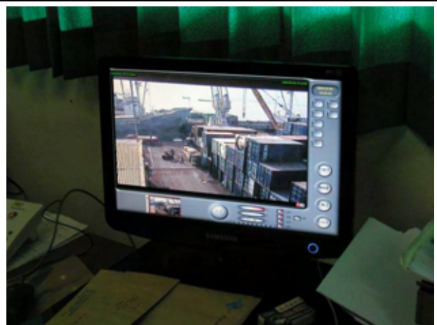
写真-6: CCTV 監視装置のモニター
