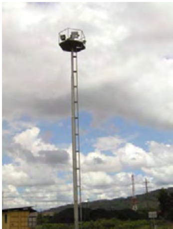
写真-3: バンテン港のセキュリティー灯
