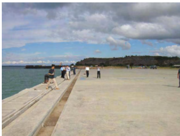
写真-6: 建設中のボジョネガラ港
