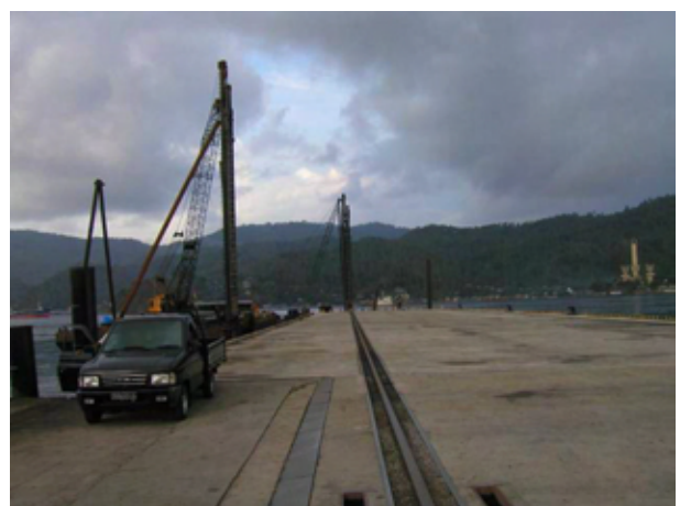
写真-6: 新港の延伸工事
