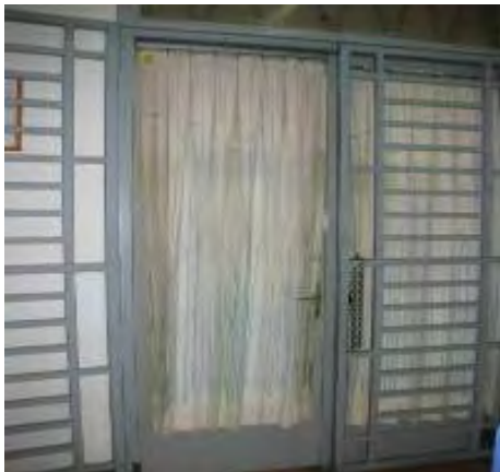
写真-3：既存ラボは格子とドアの双方に施錠することができる。
