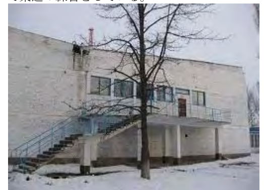
写真-7：トクモク市青少年スポーツ学校の競技場がある建物の外観。
