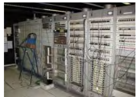
写真-5：デジタル化に向け機材更新中の中央制御室にある旧式アナログビデオパッチ盤
