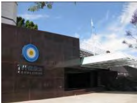
写真-1：国営放送局外観
