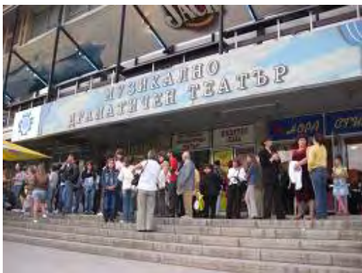
写真-1：劇場正面入口。
