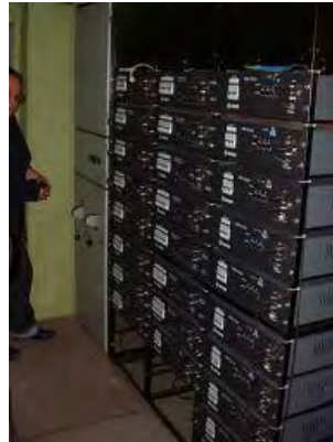
写真-8：地下に設置してあるブルガリア製調光器。調光卓と同じく2008年末に自己調達したもの。
