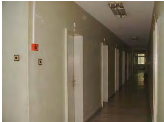
写真-15：楽屋通路。各部屋に1982年製スピーカーがありインターカムシステムからの音声を流す。
