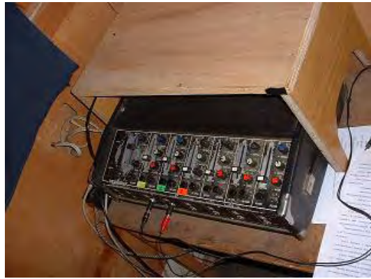
写真-18：チェンバーホールの音響機材。1970年代のもので老朽化が著しい。
