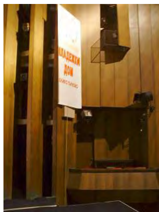
写真-13：上手プロセニウム。メインスピーカーの取付箇所。
