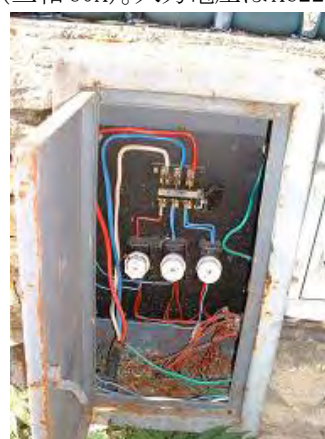
写真-16：野外劇場の分電盤（三相入力）。
