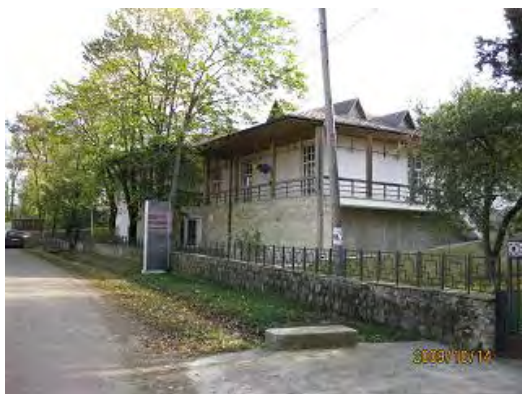
写真-1：記念館入口。屋内講堂のある建物。
