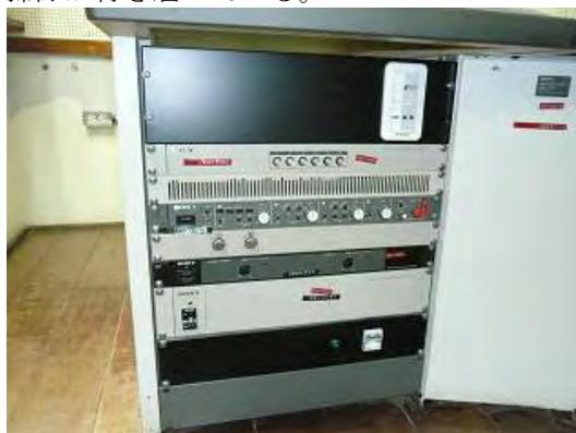
写真-6：アンプラック。使用方法のマニュアルが作成され丁寧に使用されている。
