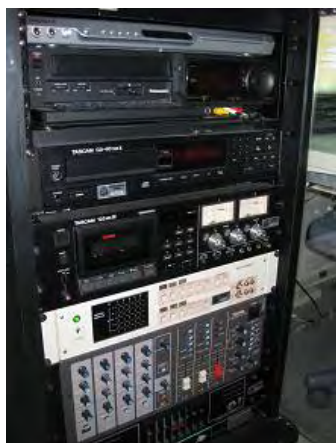
写真-9：既存 LL 機材用の音響ラック。
