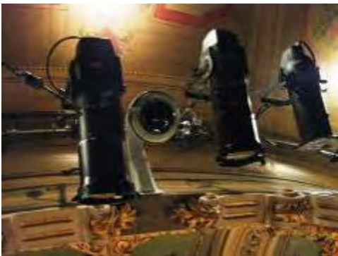
写真-5：バルコニー席3階に設置されたカメラ。撮影用カメラを監視カメラで代用している。
