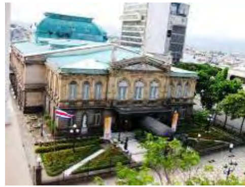
写真-2：劇場後方のドーム部分を修復中。重要歴史文化財である同劇場では、頻繁に建物内外のメンテナンスが行われている。
