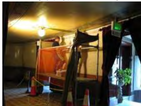
写真-24：国立劇場内 修復作業の様子
