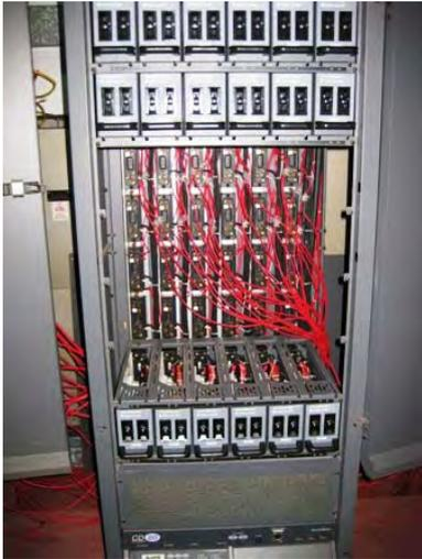
写真-9: 既存の調光器。コントロールユニットをメーカーに修理に出しているため、隣のユニットと連結して使用している。使用可能であるため、要請から削除した。
