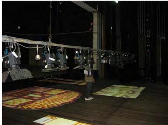
写真-10: 既存の照明器具。照明器具の数は、劇場の規模に比して不足している。
