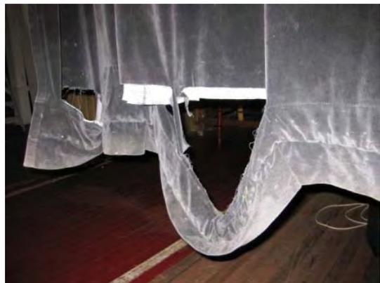
写真-12: 既存の袖幕。裾の破れが甚だしい。他にも照明機材との接触による焼け等があった。
