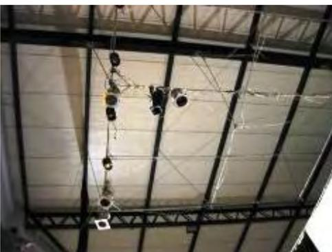
写真-5：現地調査時（2009年8月）、天井の梁から鎖で下げられた照明バトン。2010年5月現在は、工事のため撤去されている。
