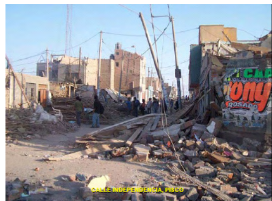
図 2-1-9 Pisco の被害の様子
