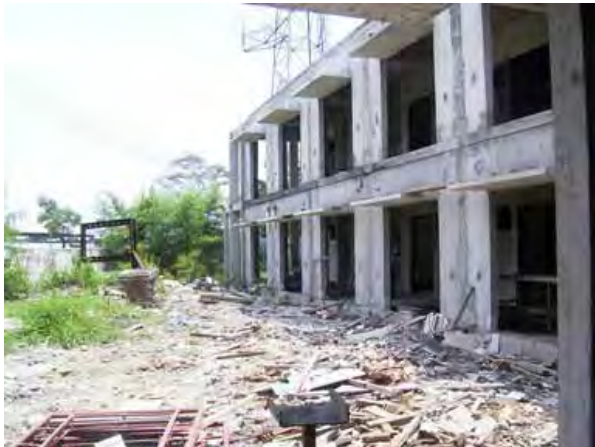
建設中の研修対象者用の宿泊棟 (ソロ)
