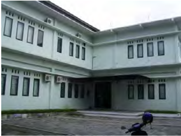
ソロにある水資源管理技術普及ユニット (DUWRMT) のオフィスビル
