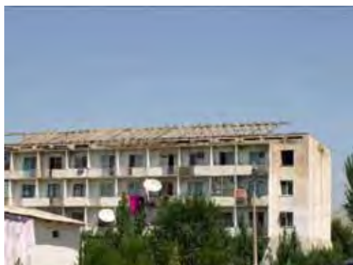
屋根の骨組み -太陽光アレイの屋根設置は構造上困難
