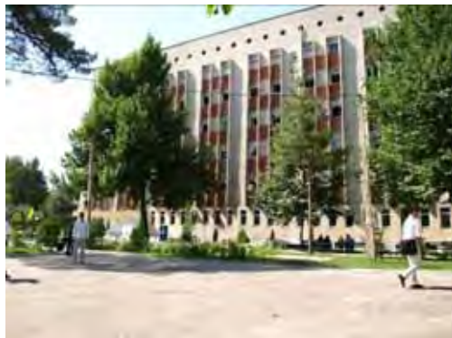
産科病棟（小児科病棟） -40kW を供給予定
