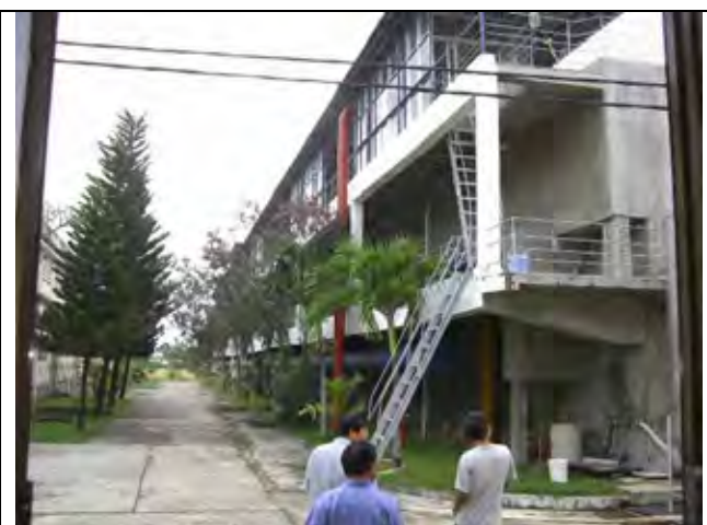
Vo Canh 浄水場(60,000m 3 /日) (2階が沈殿池とろ過池、1階が配水池の2層構造)
