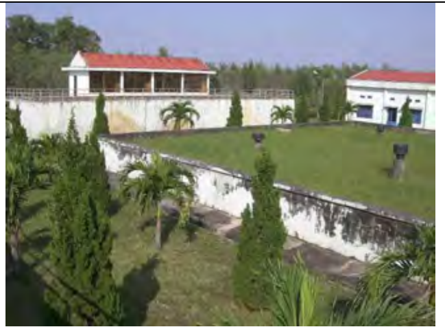
Dong Ha 浄水場のろ過池と配水池 (原水:表流水、処理能力 15,000m 3 /日)
