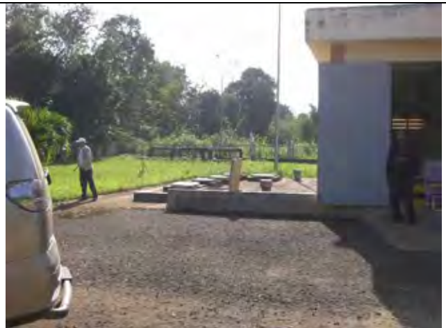
地下埋設管による地下水取水場 Uguon Cotam Groundwater Gallery
