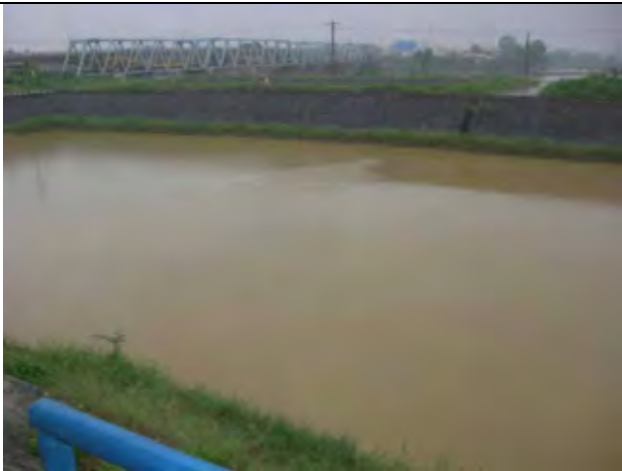
沈砂池(取水) (Cau Do 浄水場)
