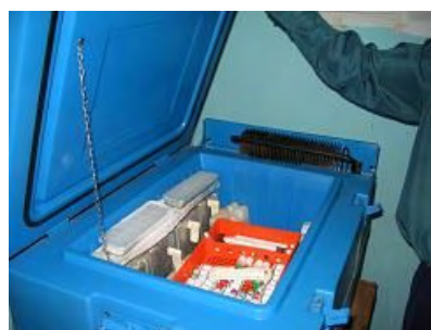
診療棟ラボラトリー室内にあるワクチン 及び輸血用血液保存用冷蔵庫
