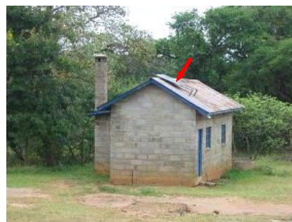
パブリックヘルスセンター (屋根上に PV パネル設置)
