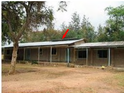
教室棟（屋根上に PV パネル設置）
