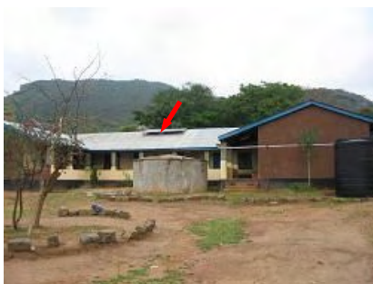
診療棟 (屋根上に PV パネル設置)
