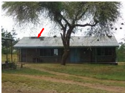
実験棟（屋根上に PV パネル設置）
