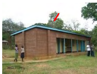
入院患者用厨房 (WC、シャワー室含む) (屋根上に PV パネル設置)
