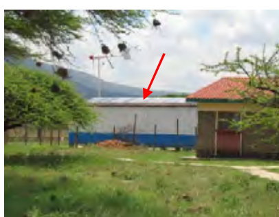
設備棟1（同左）（裏面） （屋根にPVパネルが設置されている。）
