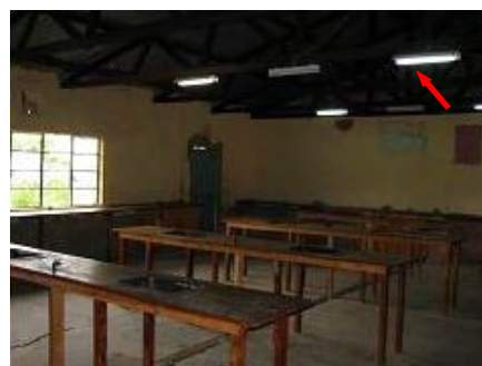
実験棟内の照明（20W 蛍光灯）
