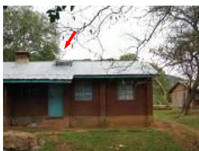
職員及びその家族用の宿舎 (屋根上に PV パネル設置)
