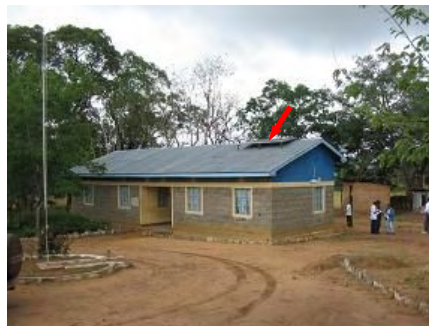
教員事務棟（屋根上に PV パネル設置）
