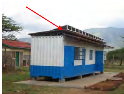
PCセンター（左）と設備室（右）（正面） （屋根にPVパネルが設置されている。）
