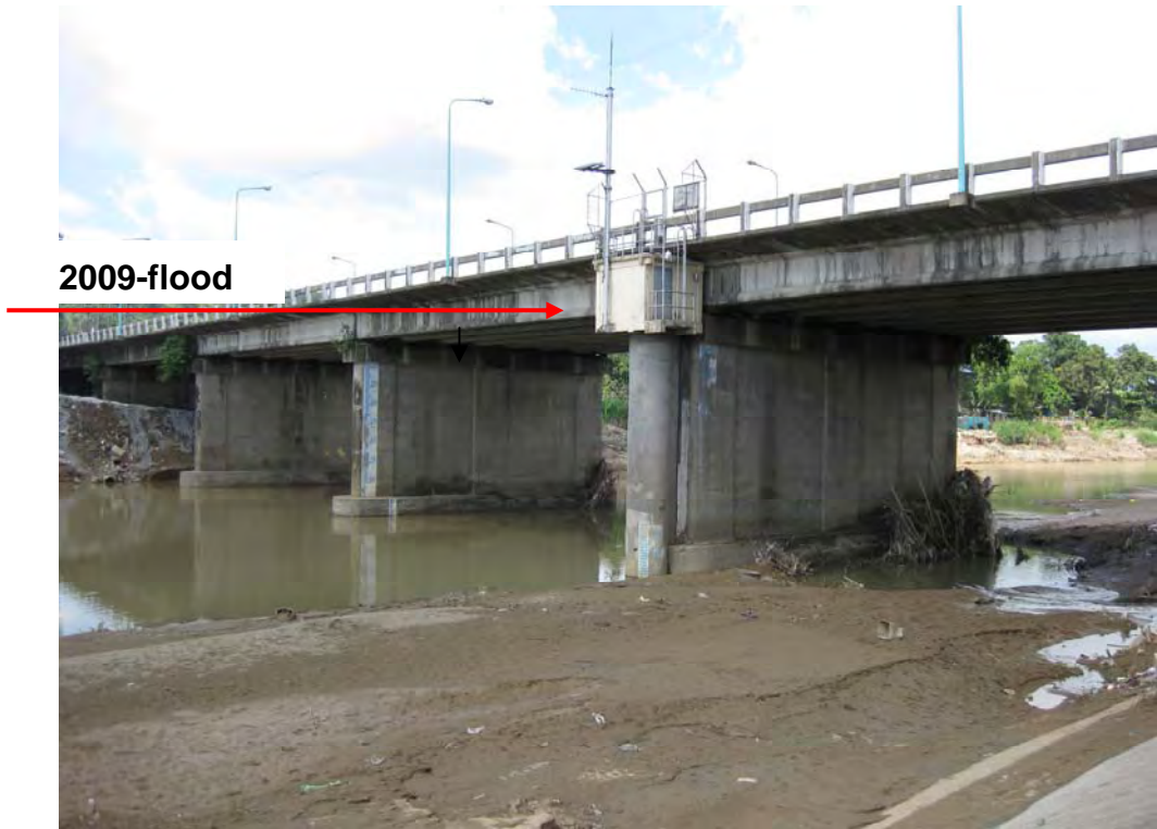
写真-15 モンタルバン橋 (下流側、水位計、マリキナ川)
