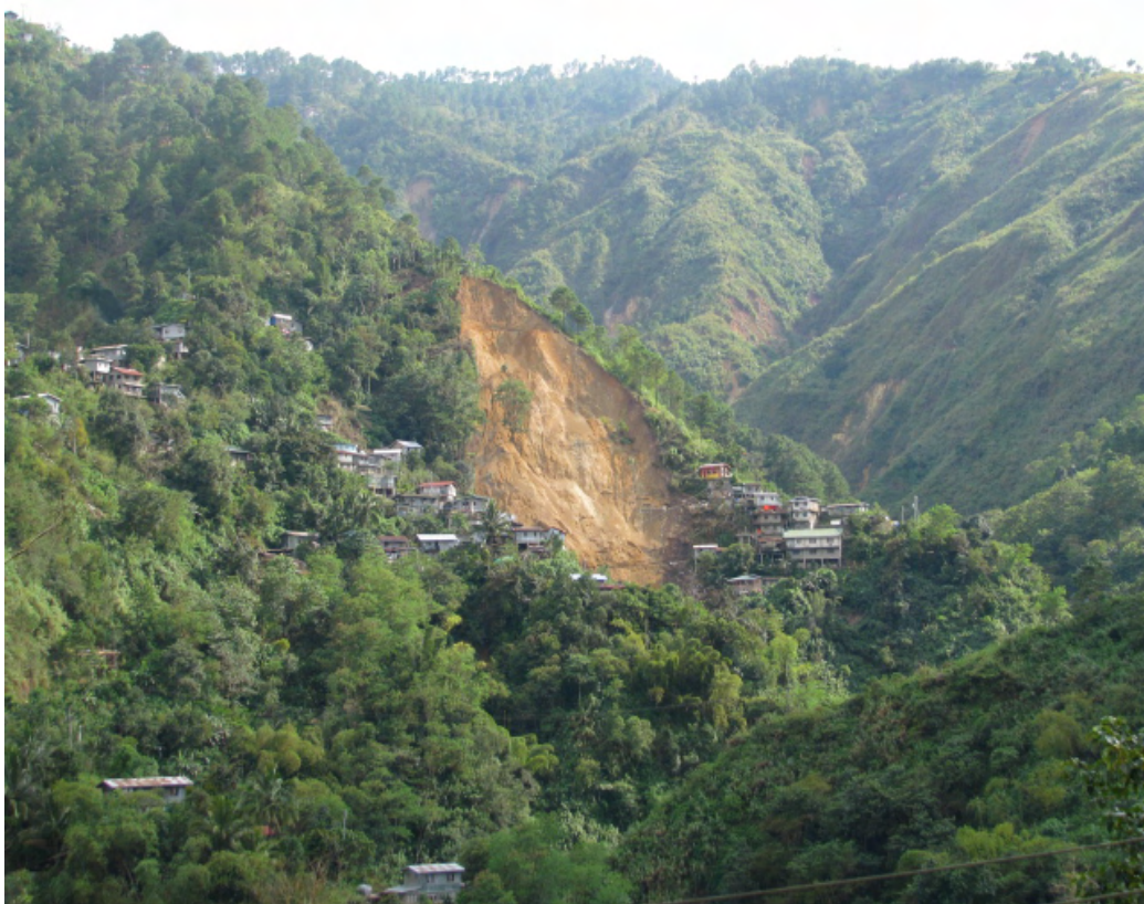
写真-22 台風ペペンによる斜面崩壊
