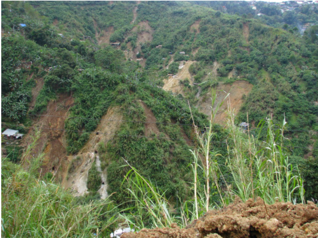
写真-21 台風ペペンによる斜面崩壊
