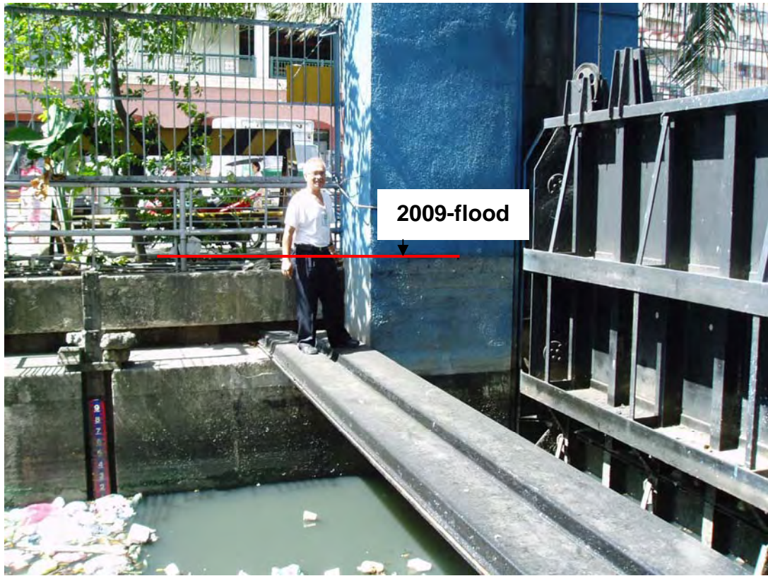
写真-3 パンダカン ポンプ排水機場 (排水ゲート、メトロマニラ)
