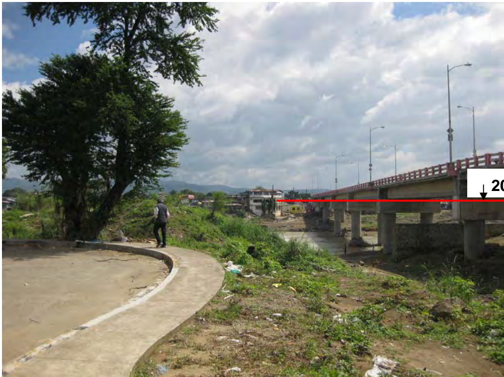
写真-14 トウマナ橋 (下流側、マリキナ川)
