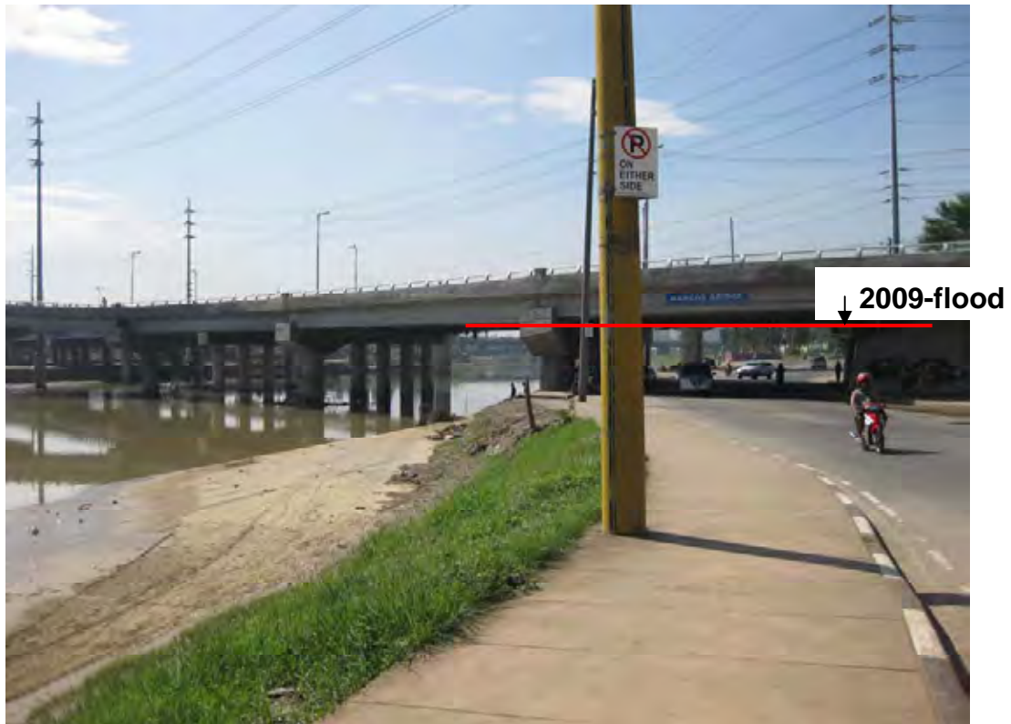
写真-7 マルコス橋 (上流側、マリキナ川)
