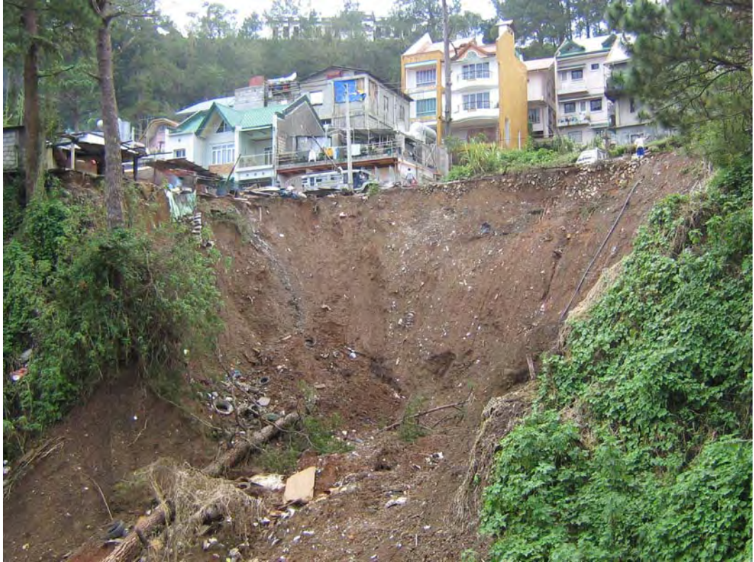
写真-23 台風ペペンによる斜面崩壊
