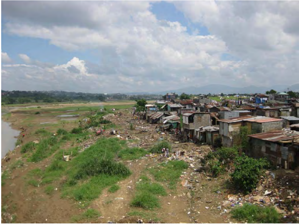
写真-13 トウマナ橋 (下流側を望む、マリキナ川)
