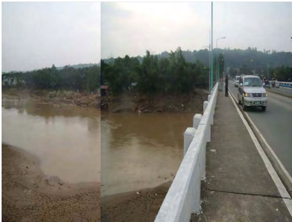
写真-12 サン・マテオ橋 (下流側を望む、マリキナ川)
