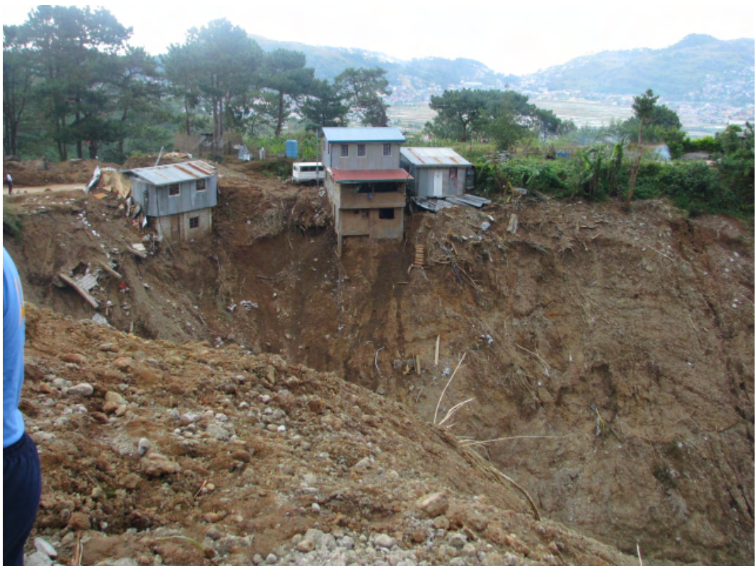
写真-24 台風ペペンによる斜面崩壊
