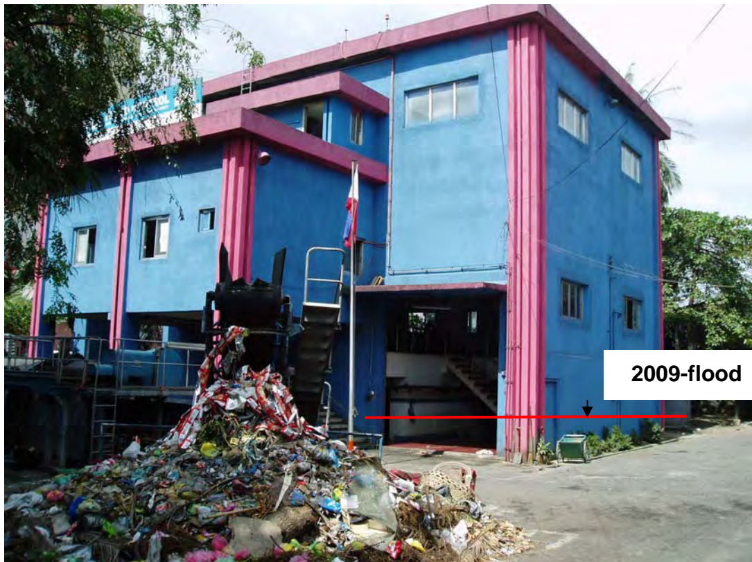
写真-2 パンダカン ポンプ排水機場 (メトロマニラ)
