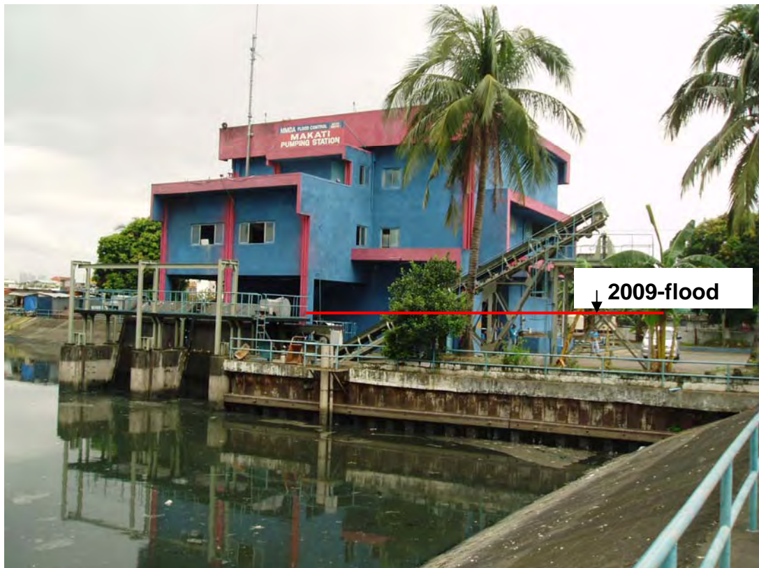
写真-4 マカティ ポンプ排水機場 (メトロマニラ)
