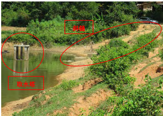
堤体上流側（右岸より左岸を望む）
