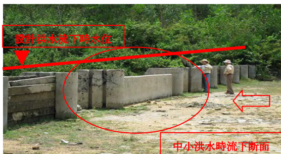
洪水吐流入部（左岸より右岸を望む）
