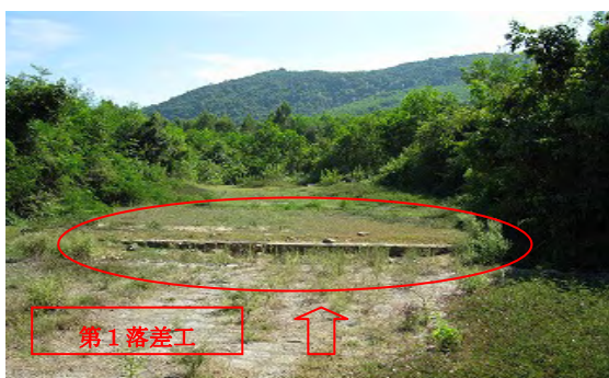
洪水吐（流入部より第1落差工を望む）
