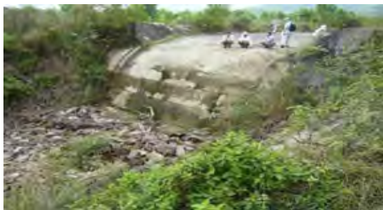
急流部と水叩き（下流左岸より望む）
