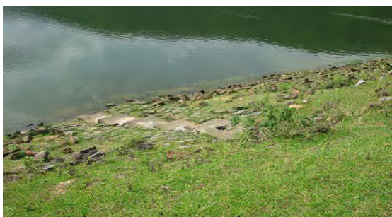
取水部(斜樋、堤体右岸に位置)
