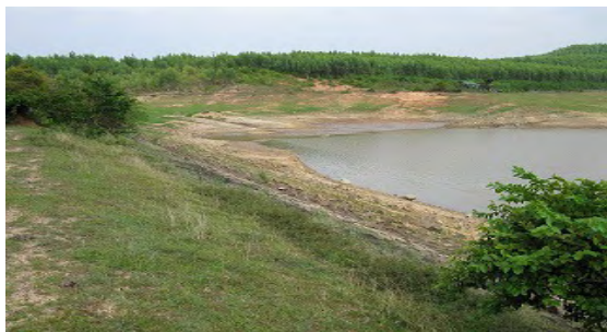
堤体上流側（左岸より右岸を望む）
