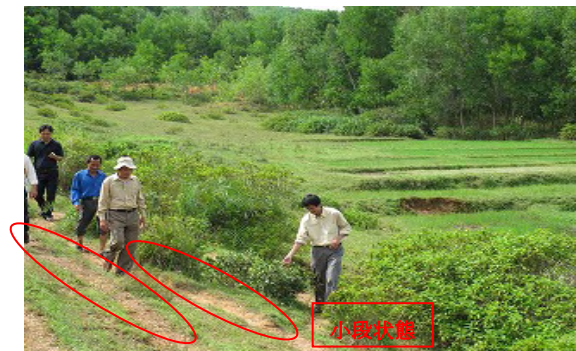
堤体下流側（右岸より左岸を望む）
