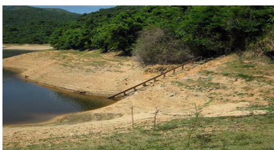
取水部（斜樋、貯水池左岸に位置）
