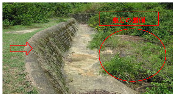
洪水吐下流落差工（右岸より左岸を望む）
