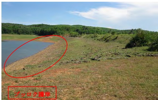
堤体上流側（右岸より左岸を望む）
