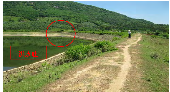
堤体上流側(右岸より左岸を望む)
