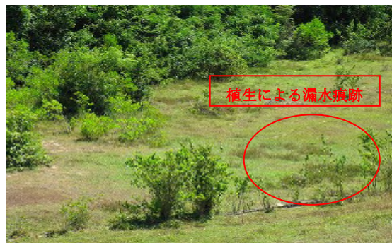
堤体下流側（左岸より右岸を望む）
