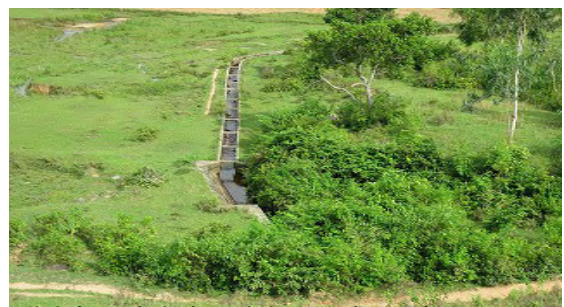
導水部下流水路(貯水池天端より望む)
