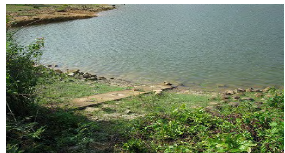
取水部（斜樋、堤体右岸に位置）
