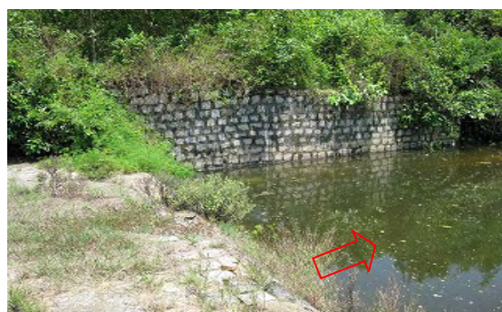
第2落差工（右岸より左岸を望む）
