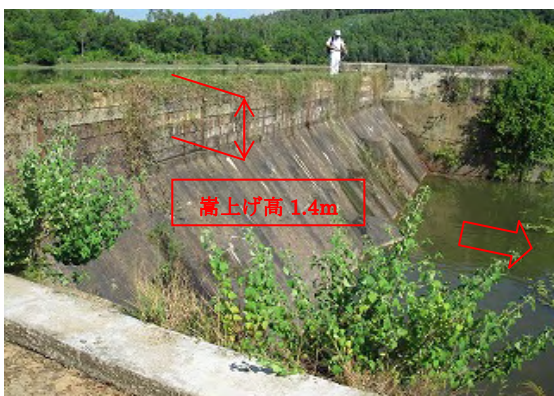
洪水吐（角落し有り、右岸より望む）
