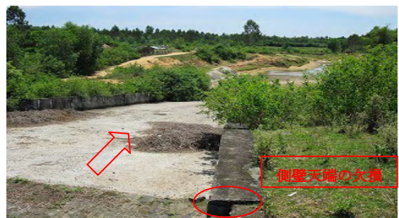
洪水吐(急流部より下流を望む)
