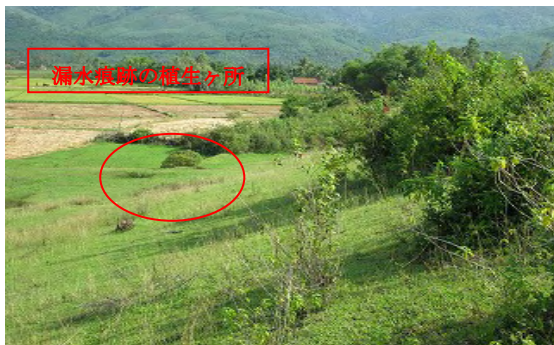
堤体下流側（左岸より右岸を望む）
