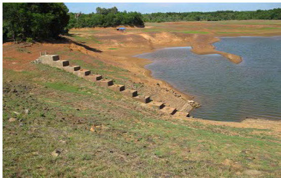
取水部（斜樋、貯水池右岸に位置）
