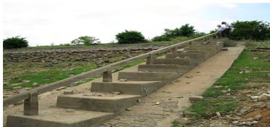
取水部（斜樋、下段から堤体天端を望む）
