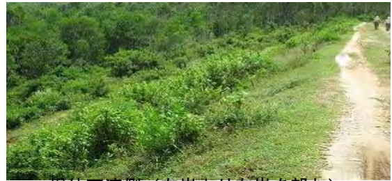
堤体下流側（左岸より右岸を望む）
