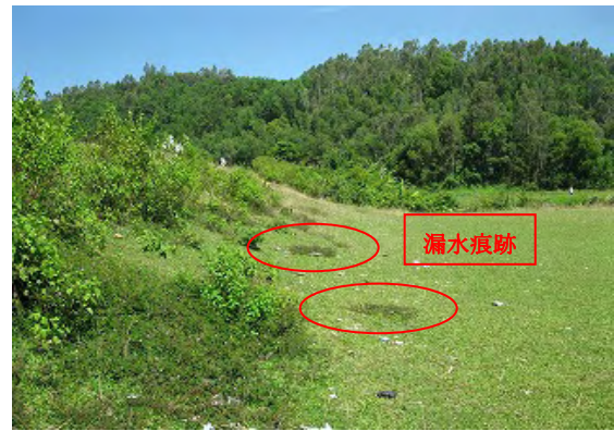
堤体下流側（右岸より左岸を望む）
