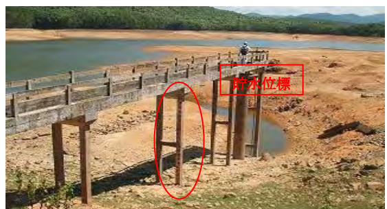
取水部（取水塔、貯水池左岸に位置）
