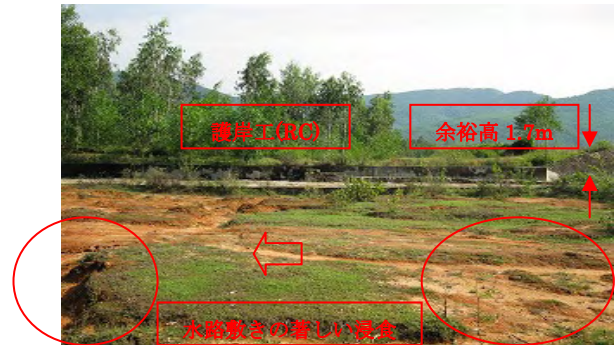
洪水吐流入部直下（左岸より右岸を望む）
