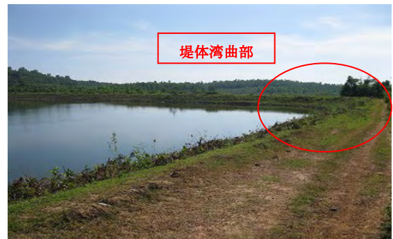
堤体上流側（右岸より左岸を望む）
