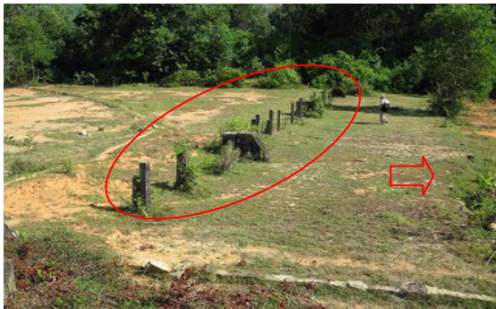
洪水吐流入部（右岸より左岸を望む）
