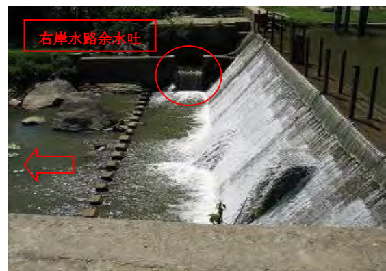
洪水吐（角落し無し、左岸より望む）
