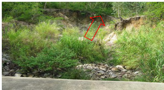
水叩き下流水路（急流部天端より望む）
