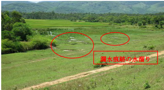
堤体下流側(左岸より右岸を望む)
