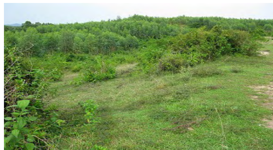
堤体下流側（左岸より右岸を望む）
