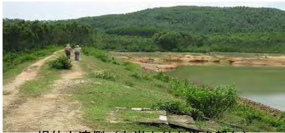
堤体上流側（左岸より右岸を望む）
