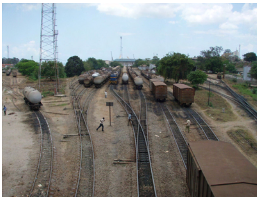
列車集積場の様子 (ゲレザニ跨線橋下)
