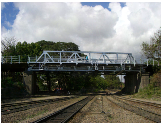
写真 4-2 既存橋の側面
