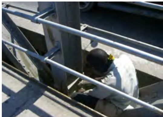
写真 4-6 錆除去および補修塗りの作業風景
