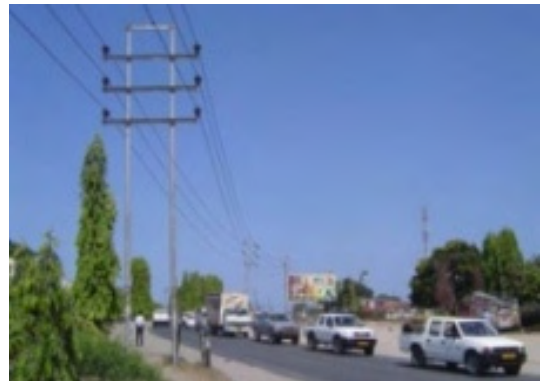
写真 5-5 支障物：33kv 配電線（バンダリ道路）
