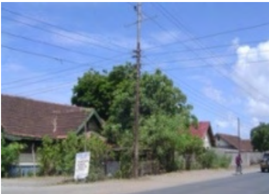
写真 5-4 支障物：11kv 配電線（ゲレザニ道路）
