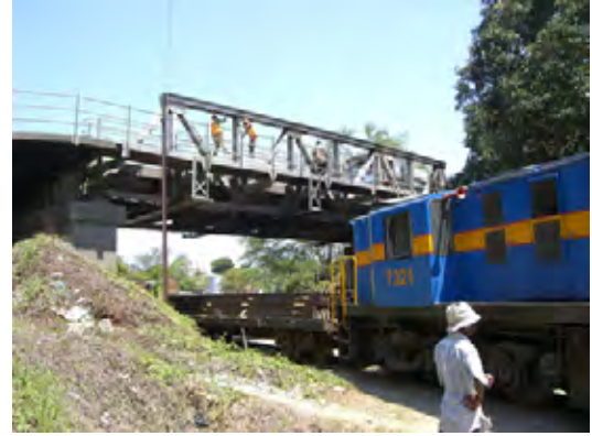
写真 4-9 ゲレザニ橋下から見た山側の配線状況
