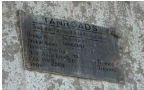
写真 4-1 橋台に取り付けられた橋歴板
