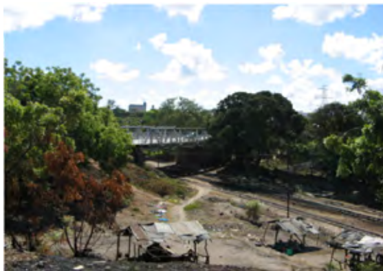
写真 3-3 台地側から見た跨線橋：鉄道のあるところは低地；高低差約 7m
