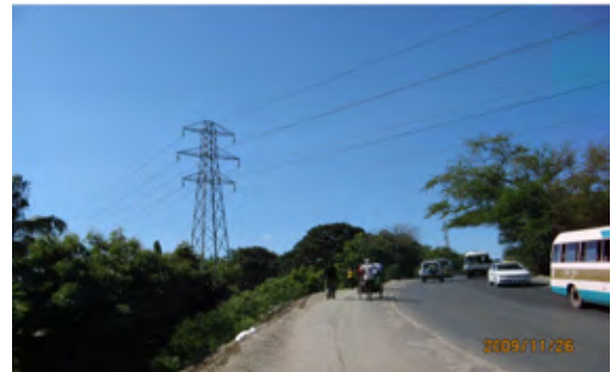
写真 3-4 跨線橋西側の盛土区間；高さ約 7m
