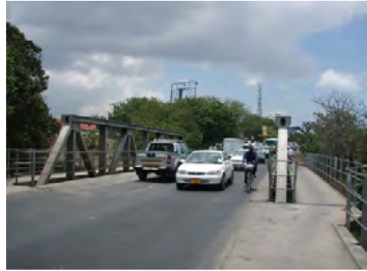
ゲレザニ跨線路橋
