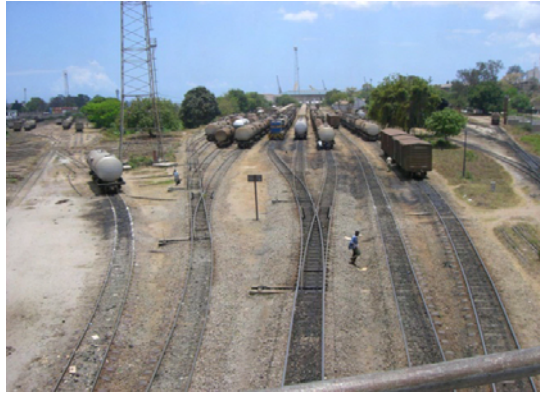
写真 4-8 ゲレザニ橋より見た海側の配線状況
