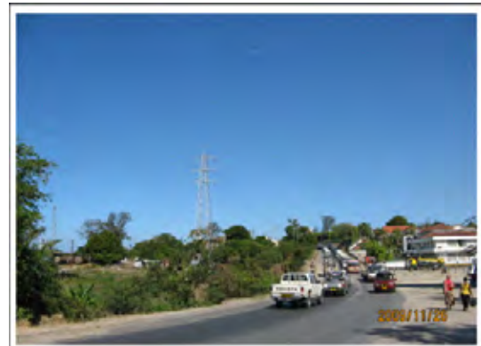
写真 3-16 BP 前の鉄道用地内の送電鉄塔
