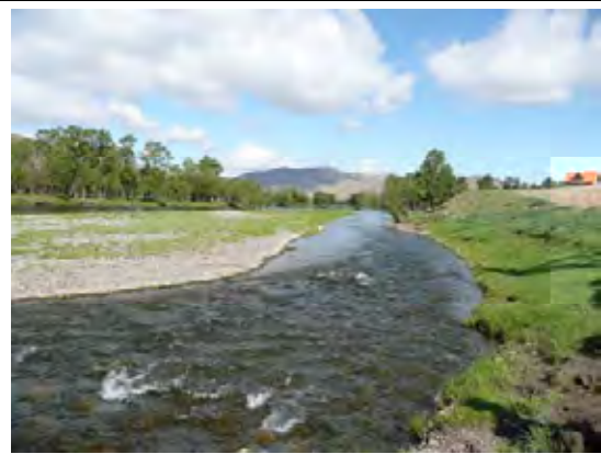
トーラ川における送配水管横断部。横断管は、360°巻コンクリートで防護の上、河床より2mの土被りを確保して伏越しする。
