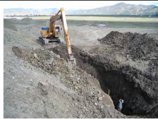
ガチョルト道路沿い、下水管路敷設の掘削状況。本計画送配水管の敷設においては、冬季の凍結防止のため管路心被りを3.5m確保する。
