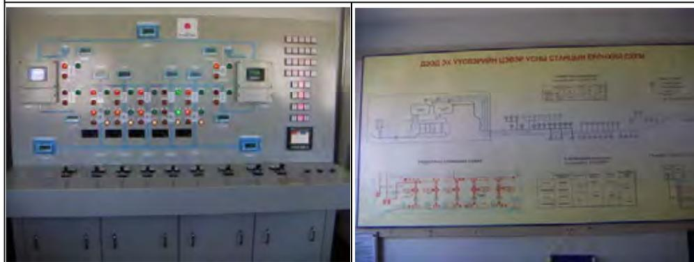
写2-1.13 上流水源遠方監視操作設備 (1箇所落雷により取水ポンプの遠方操作ができない)
