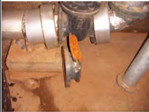
写2-1.4 破損したバルブを取り外して取替え
