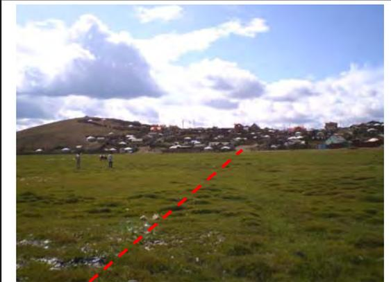
ウリアスタイ川氾濫源（湿地帯）。洪水時における送配水管沿いの管理用車両の通行を可能とするため、送配水管上部に「地盤高+1.0m」の盛土を行う。
