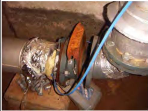
写2-1.3 凍結で破損したバルブ
